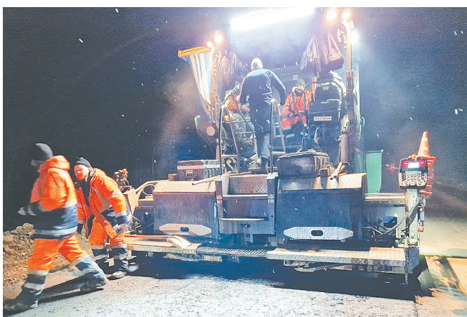
Министр транспорта ДНР Владимир ТУЖИЛИН проинспектировал ход работ по восстановлению автомобильной дороги Донецк – Харьцызск – Амвросиевка – КПП «Успенка».
